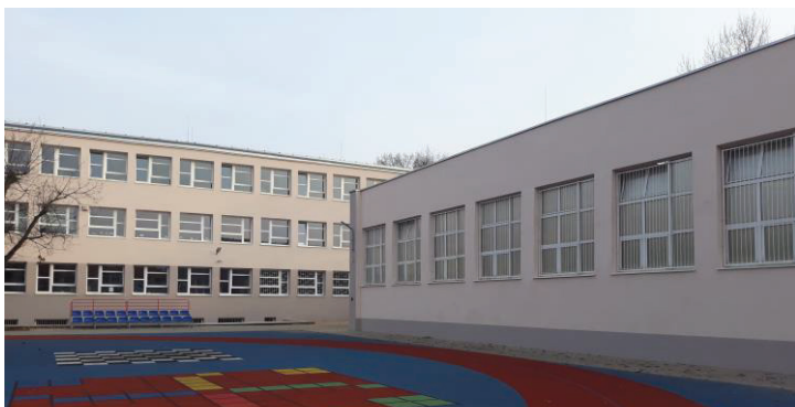
Szkoła po termomodernizacji – rok 2018
