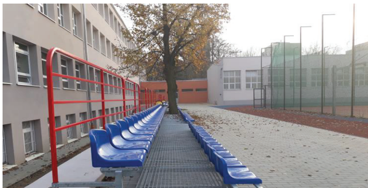
Szkoła po termomodernizacji – rok 2018
